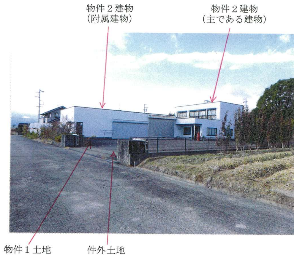
① 物件 1 土地、物件 2 建物、件外土地の外観
