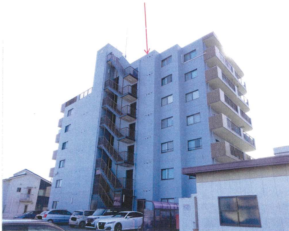
物件1 建物を含む一棟の建物
