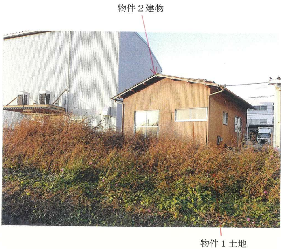
② 物件 1 土地、物件 2 建物の外観
