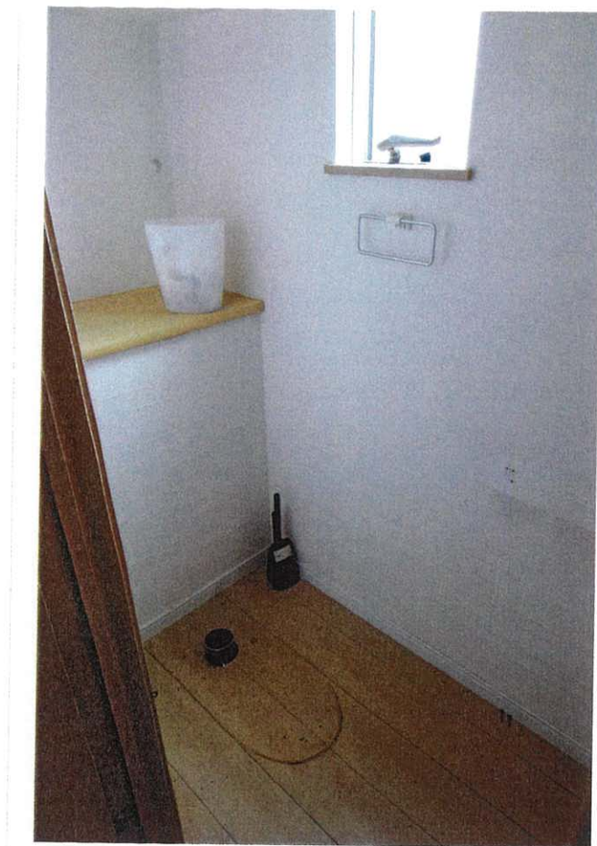
⑦ 便器の撤去状況（1階トイレ）
