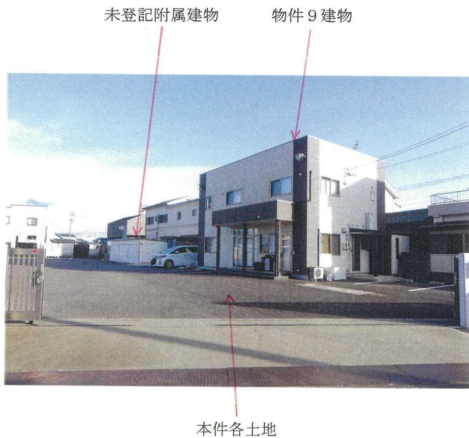
② 本件各土地、物件 9 建物、未登記附属建物の外観
