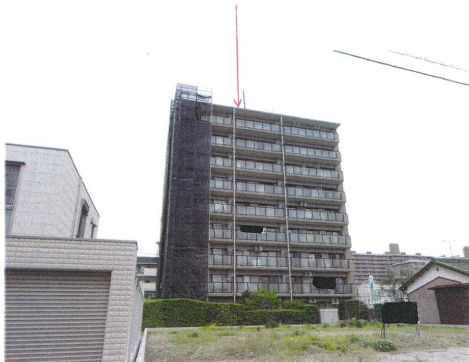
物件 1 建物を含む一棟の建物
