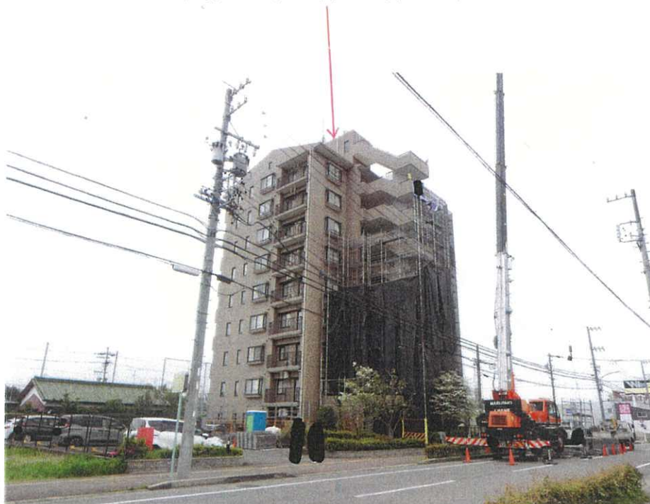
物件 1 建物を含む一棟の建物
