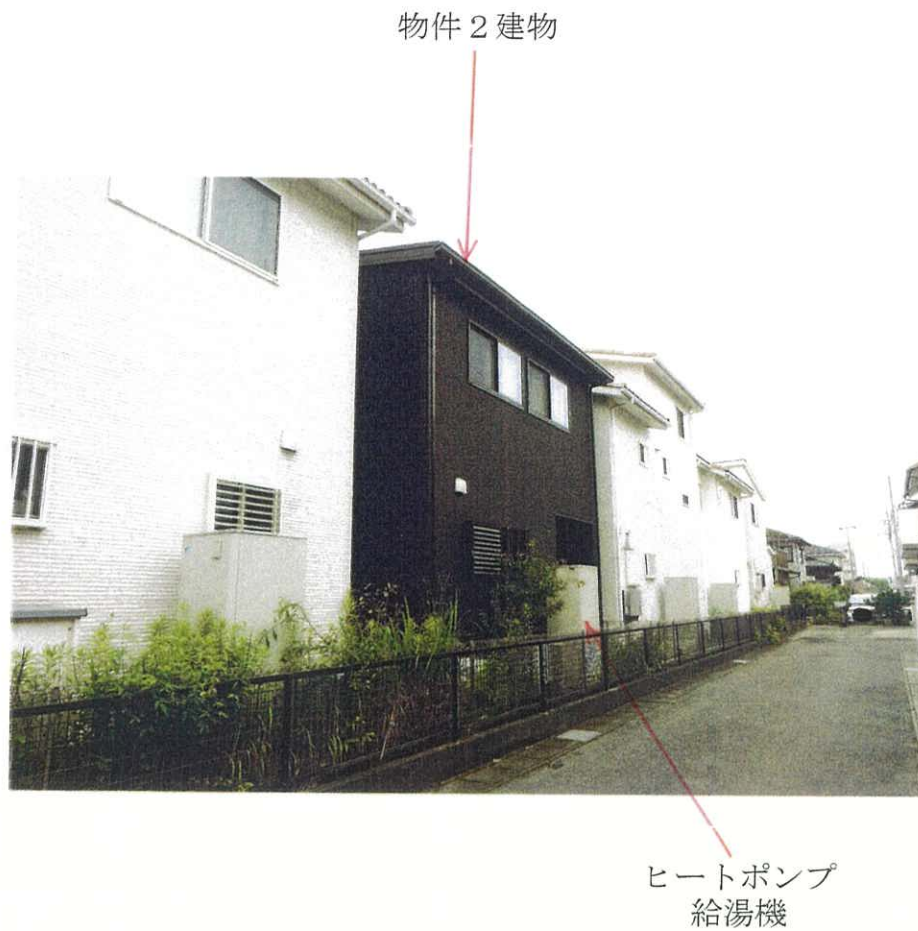
② 物件 2 建物の外観
