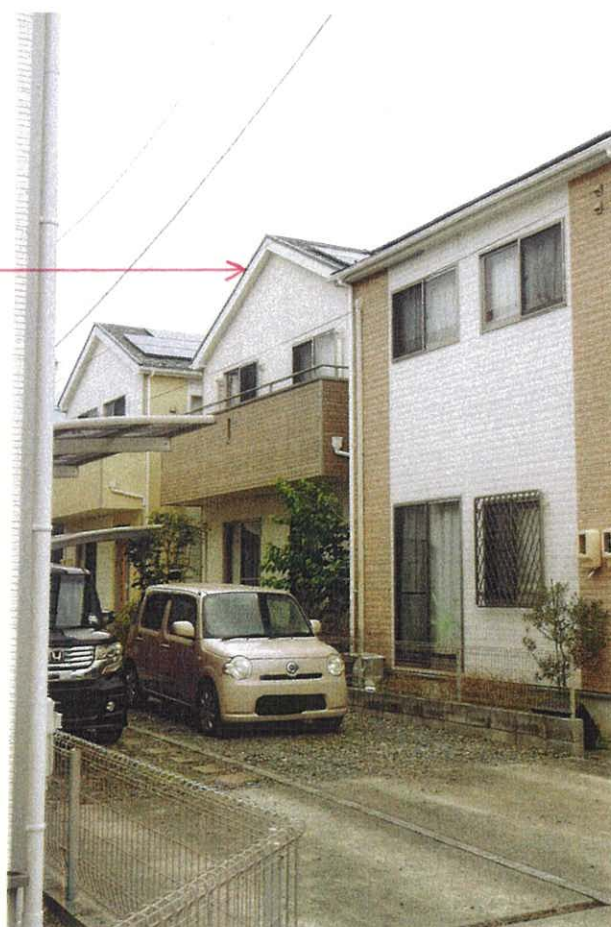
② 物件 2 建物の外観
