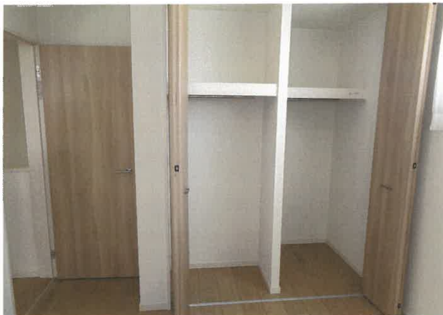
屋内の状況 洋室2
