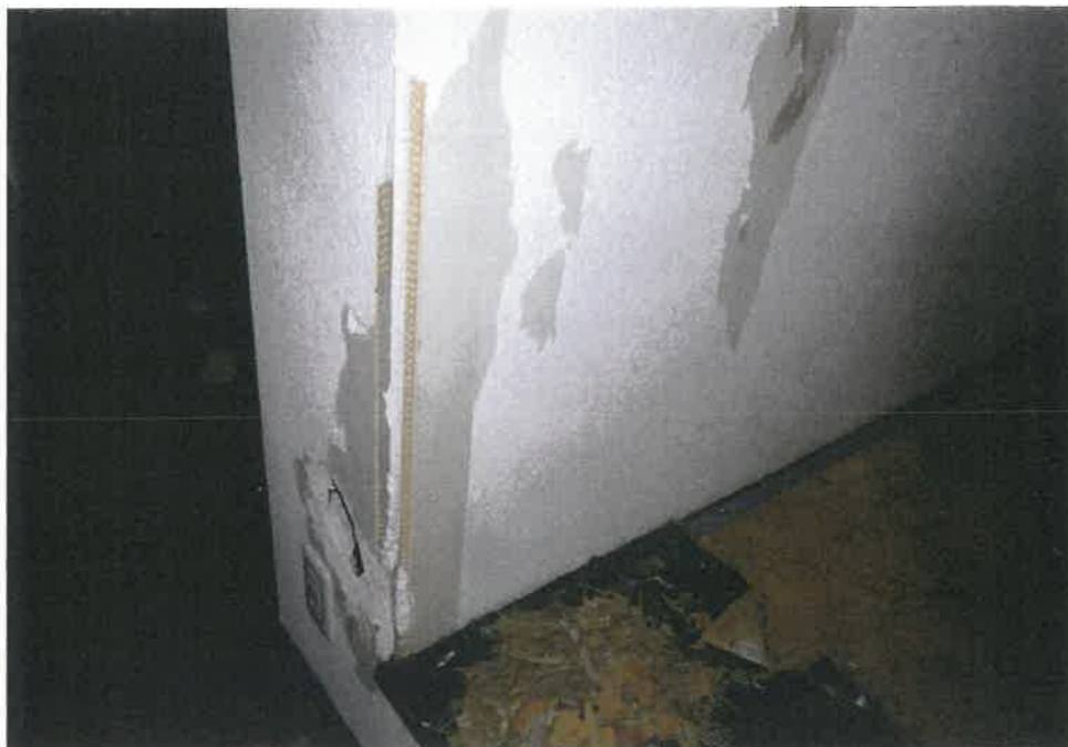
⑥屋内の状況 リビング・ ダイニング の壁の状況
