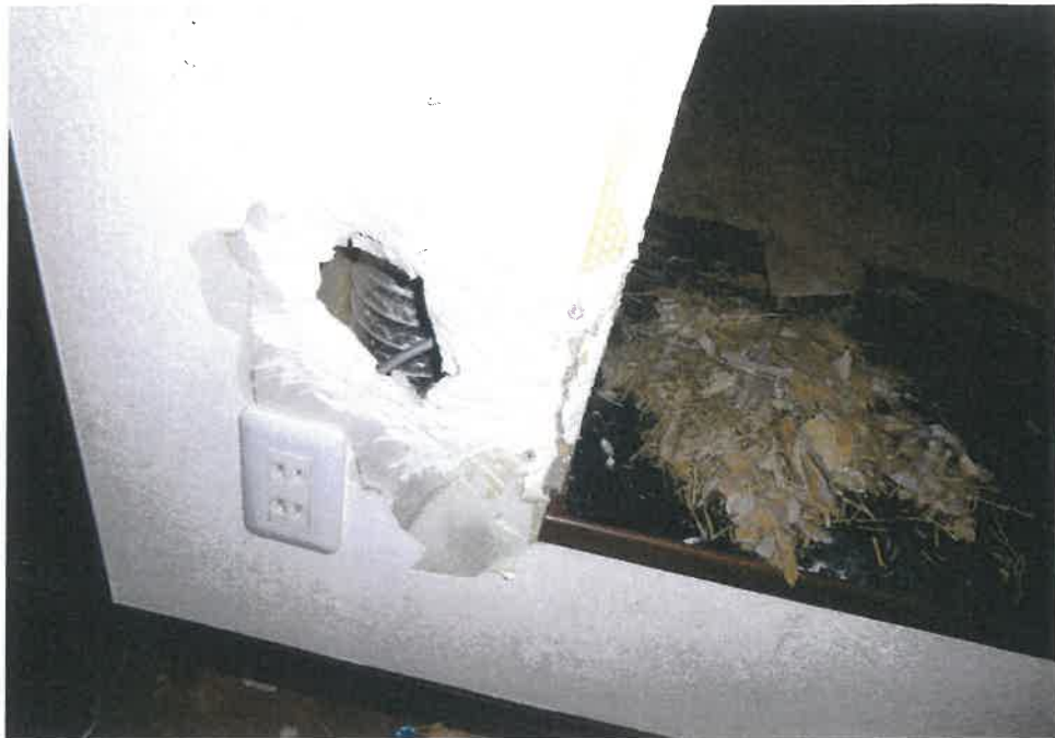
⑤屋内の状況 リビング・ ダイニング の壁の状況
