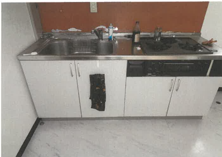
⑦ 屋内の状況 3階 店舗2 流し台
