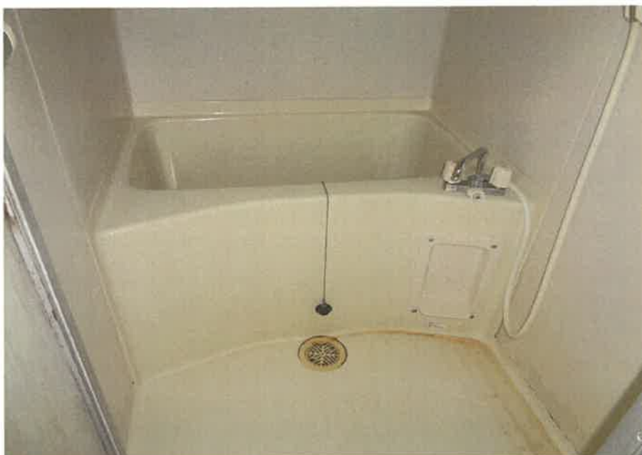
⑧ 屋内の状況 浴室
