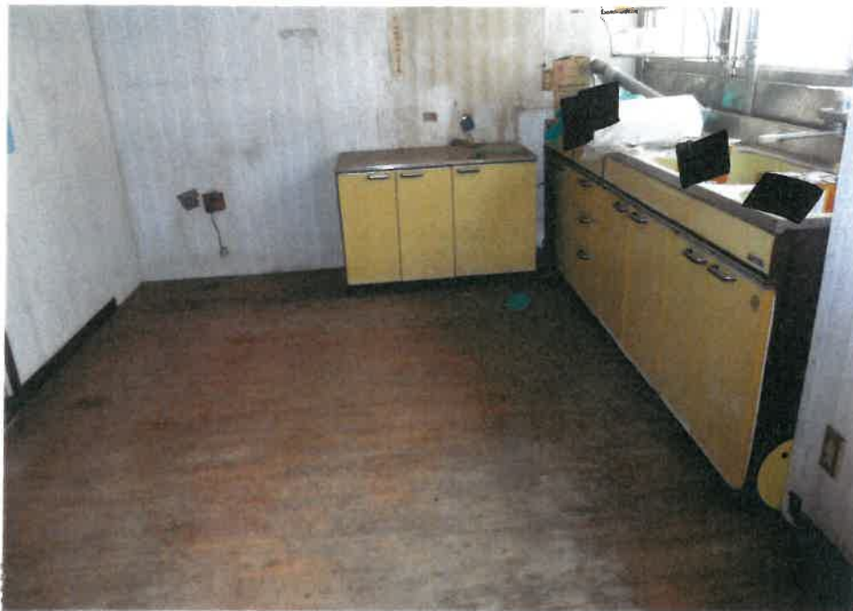
⑨屋内の状況 台 所 (物件3)
