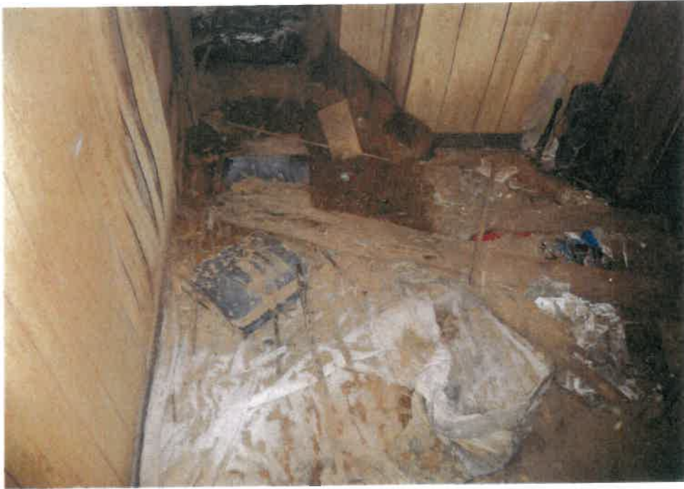
⑬ 屋内の状況 廊下の状況 (物件3)
