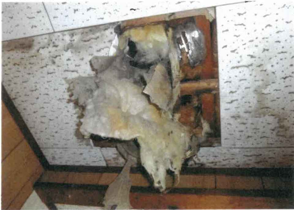
⑪屋内の状況 洋室①の天井 の状況
