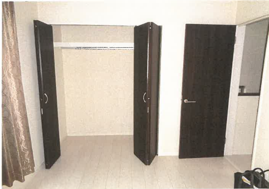
屋内の状況 洋室3
