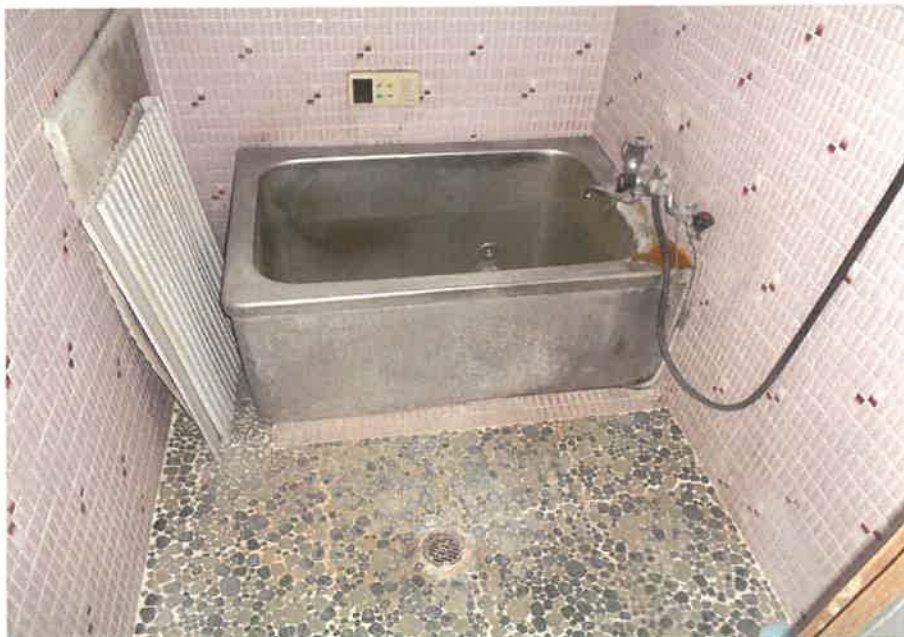
屋内の状況 浴室
