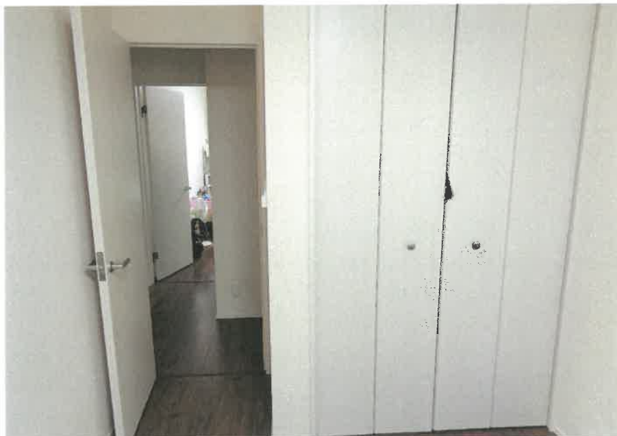
屋内の状況 洋室1
