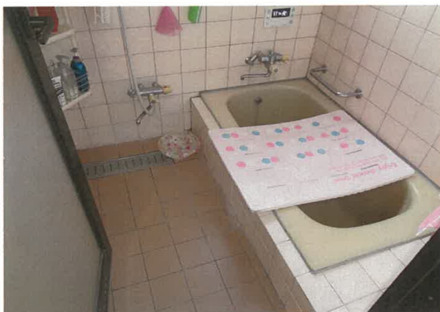
屋内の状況 浴室
