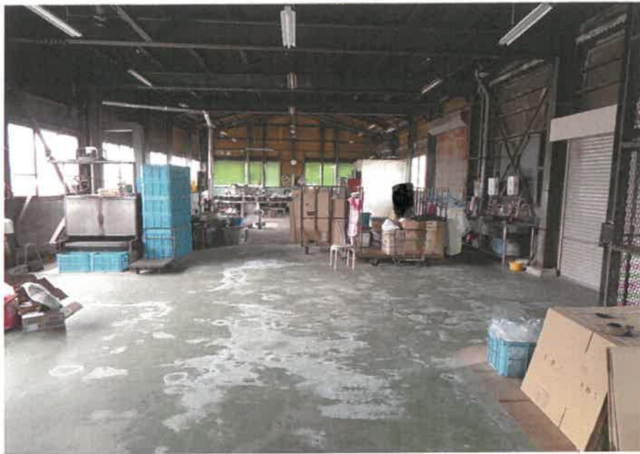
③ 屋内の状況 物件6主である建物 工場
