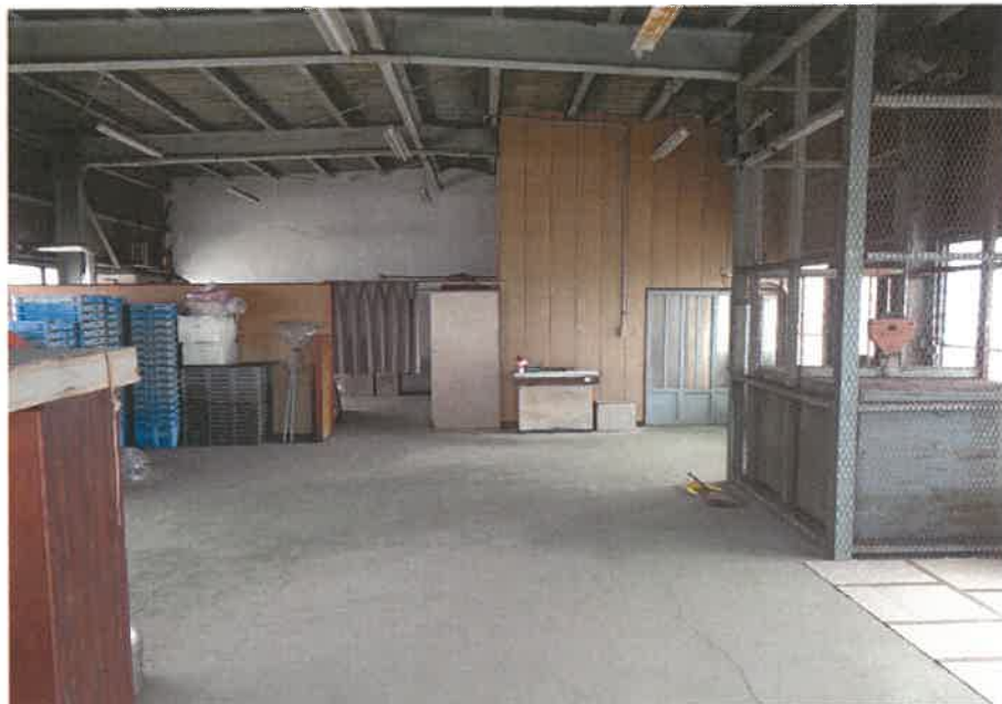
④ 屋内の状況 物件6主である建物 倉庫
