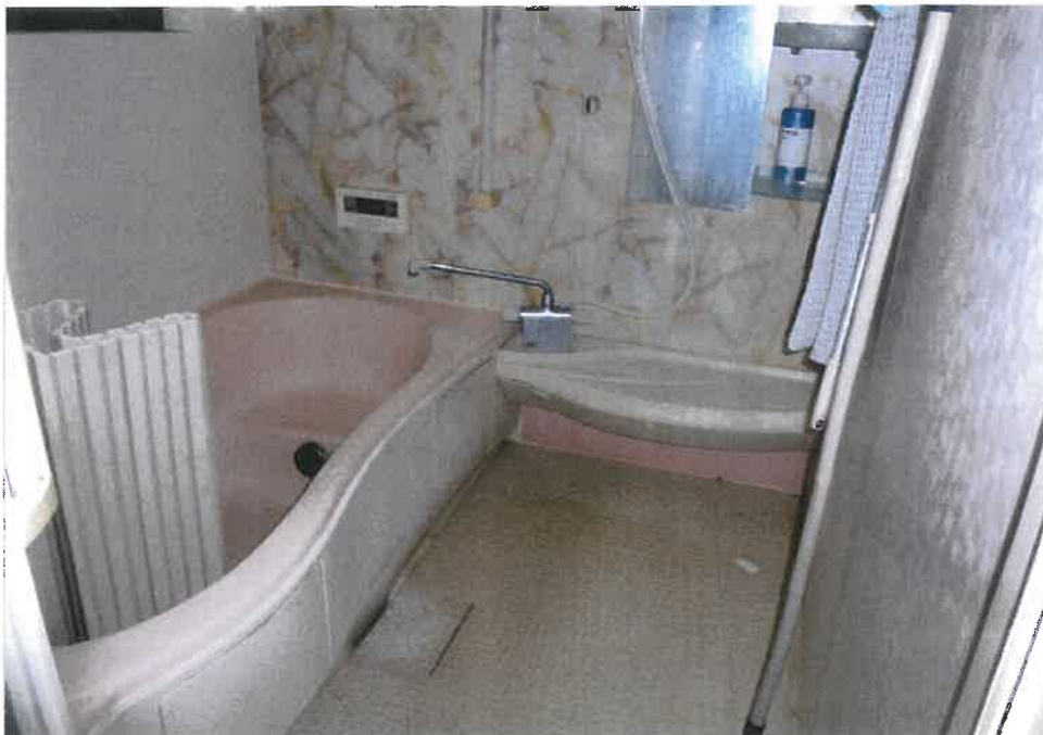
④屋内の状況 浴室
