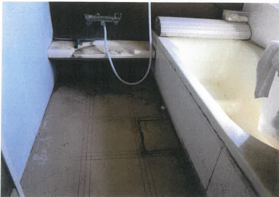
⑥屋内の状況 浴室
