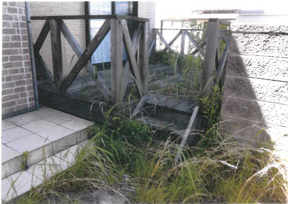
⑦屋外の状況
