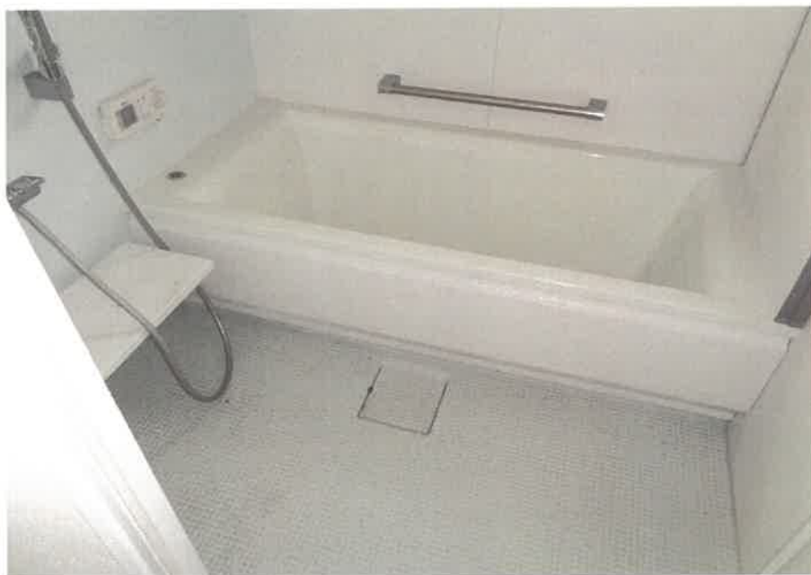
屋内の状況 浴室
