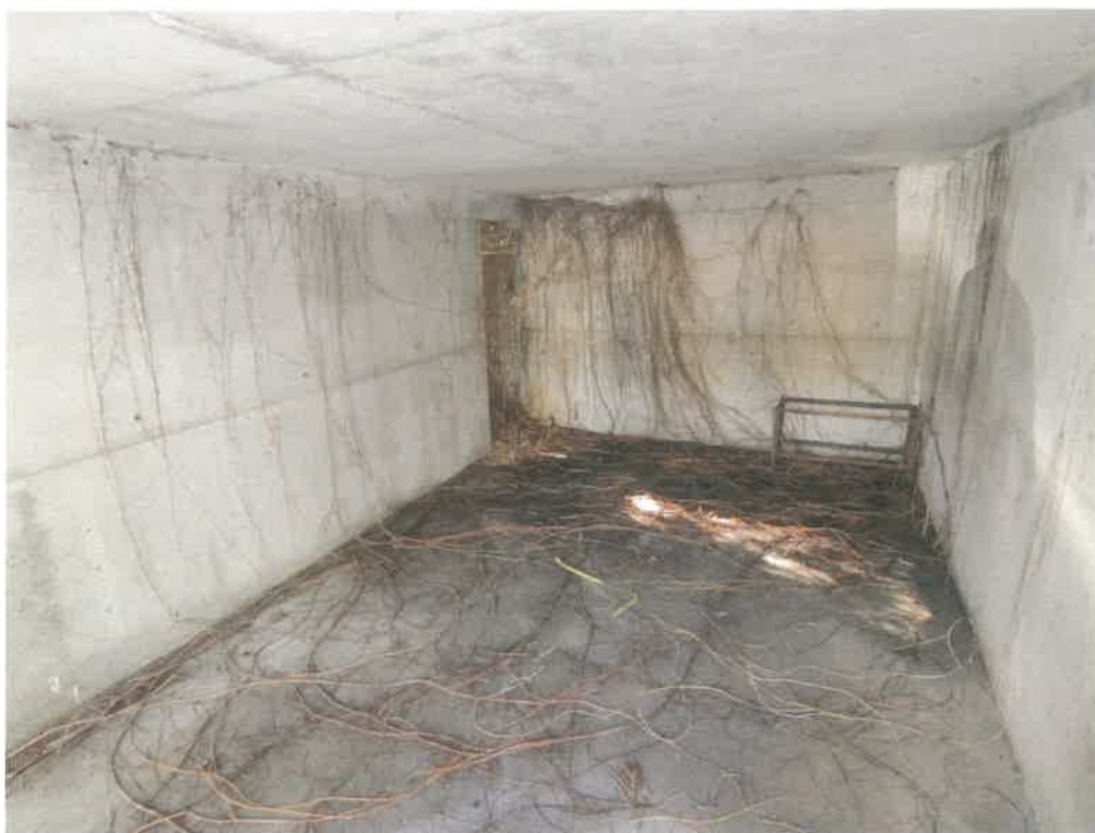
3 3 物件 1 0 附属建物 5 内部の状況（車庫）
