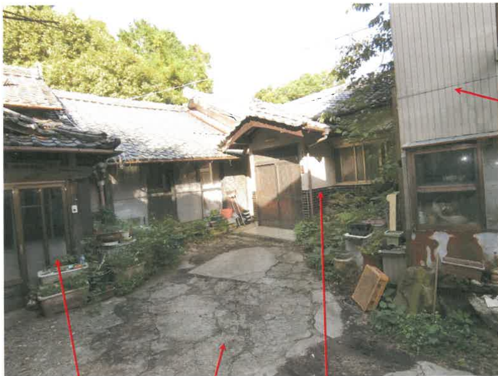
6 物件10主建物，附属建物2及び附属建物3の外観（南西方向から撮影）
