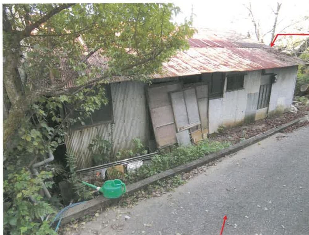
8 物件10附属建物1の外観（北西方向から撮影）
