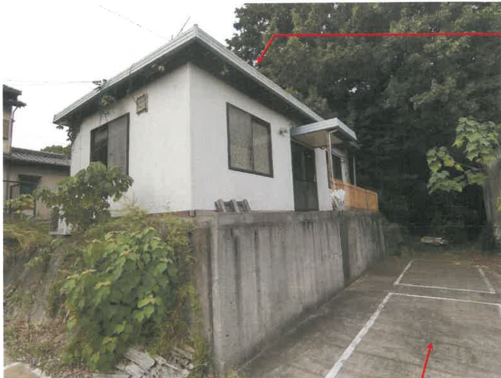
5 物件9 附属建物2の外観（南東方向から撮影）
