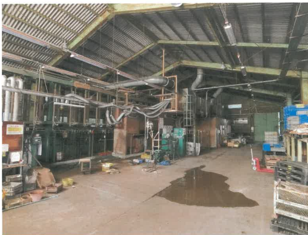
1 3 物件9 主建物内部の状況（工場北西部）
