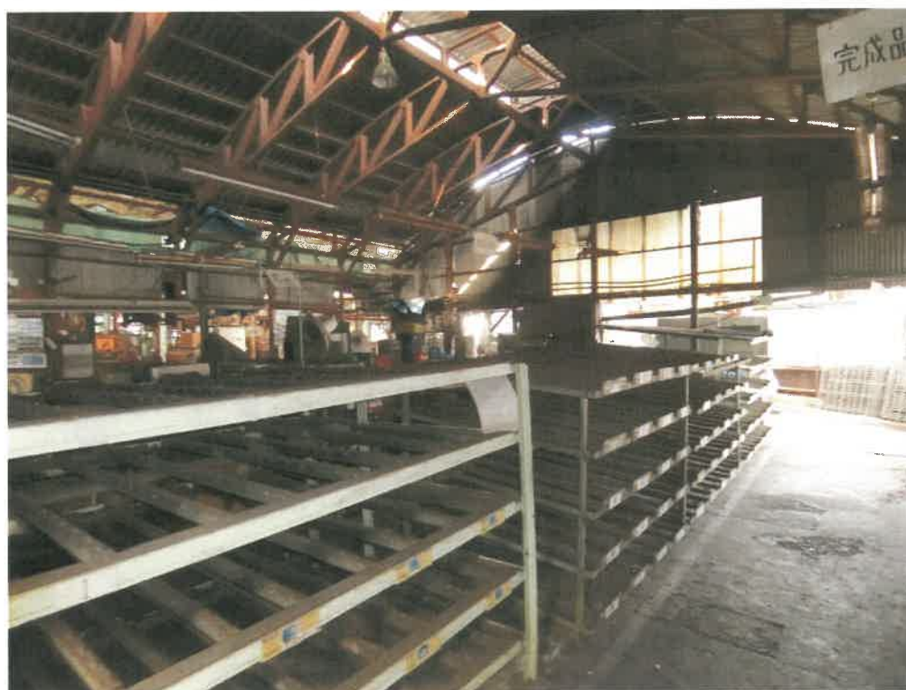
1 4 物件9 主建物内部の状況（工場南部（完成品置き場））
