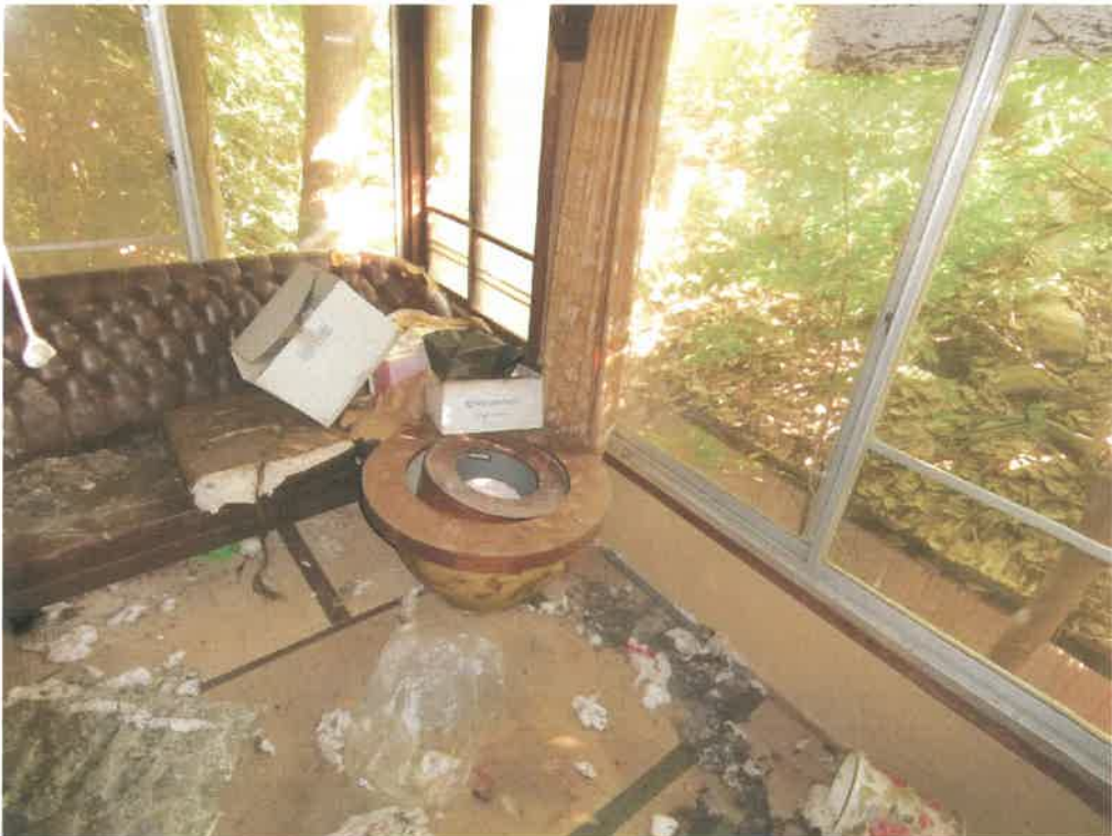
3 2 物件10附属建物4内部の状況（和室1）
