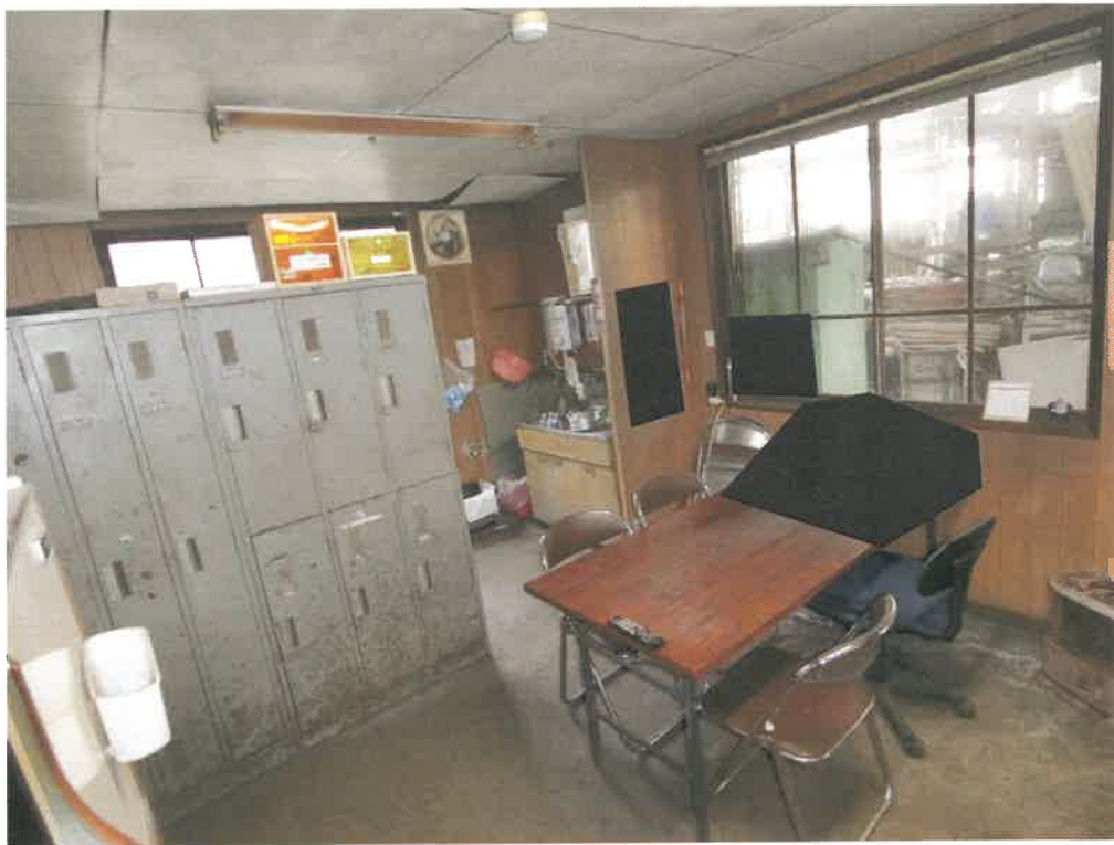
1 5 物件9 主建物内部の状況（事務室1）
