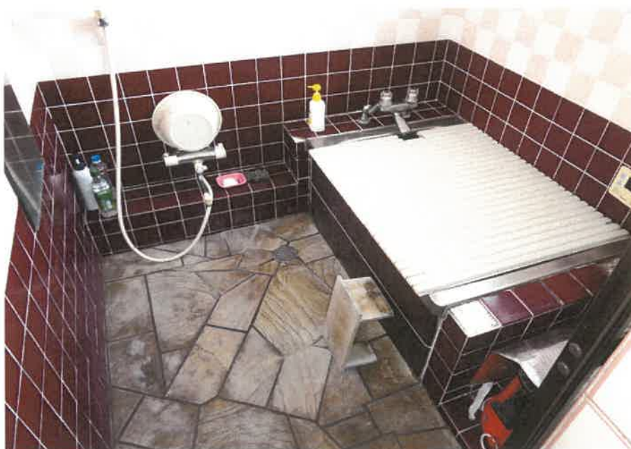
⑩ 屋内の状況 物件3建物 浴室
