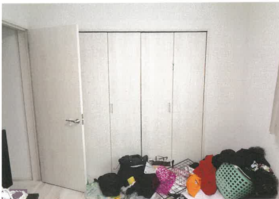
屋内の状況 洋室3
