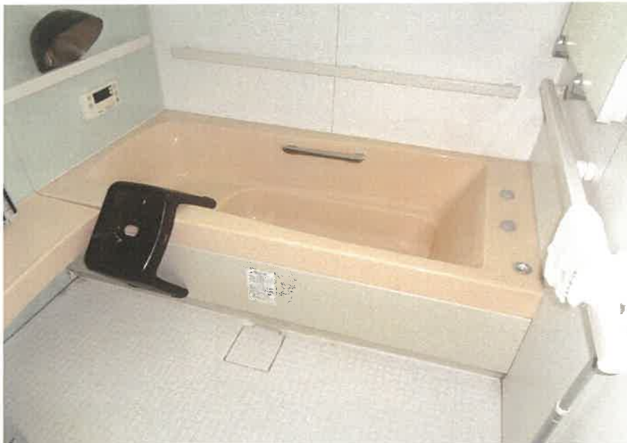
屋内の状況 浴室
