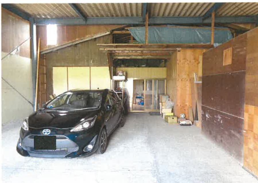
屋内の状況(未登記附属建物)
