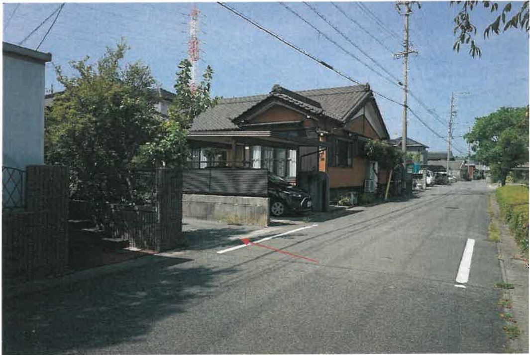
写真1 外観写真（前面道路から撮影）
