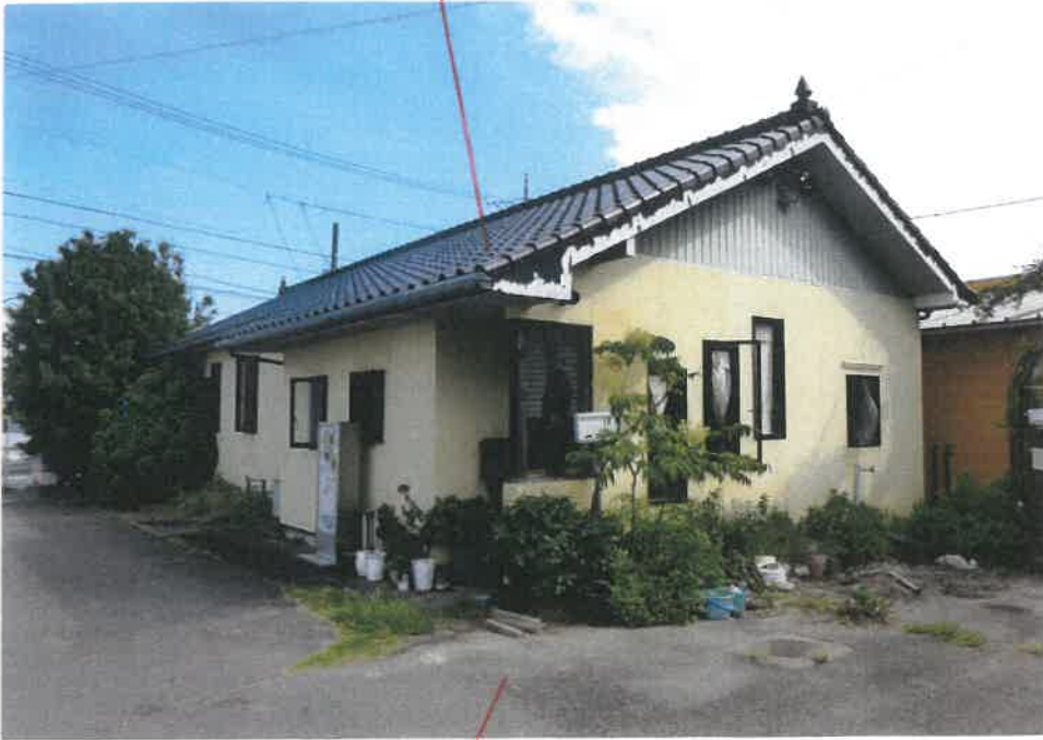
⑨屋外の状況
