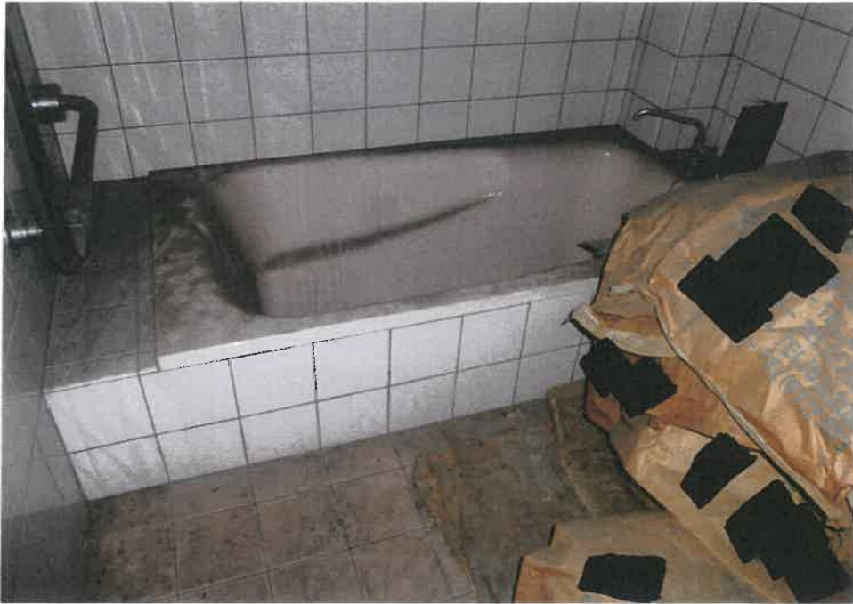
⑤屋内の状況 浴室 (物件3)
