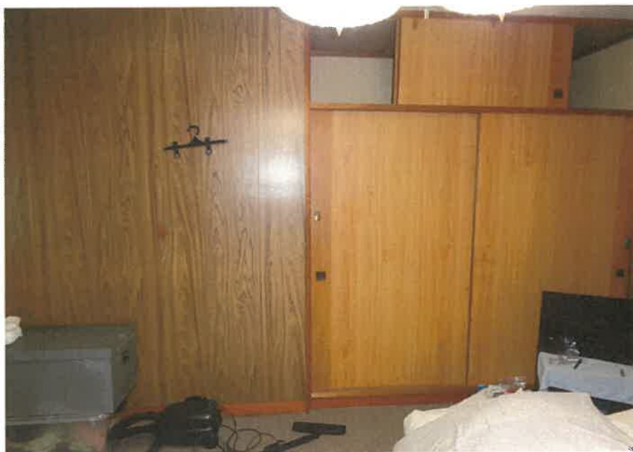
⑥ 屋内の状況 物件3建物 洋室2
