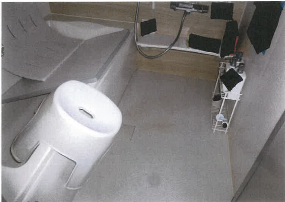
④屋内の状況 浴室
