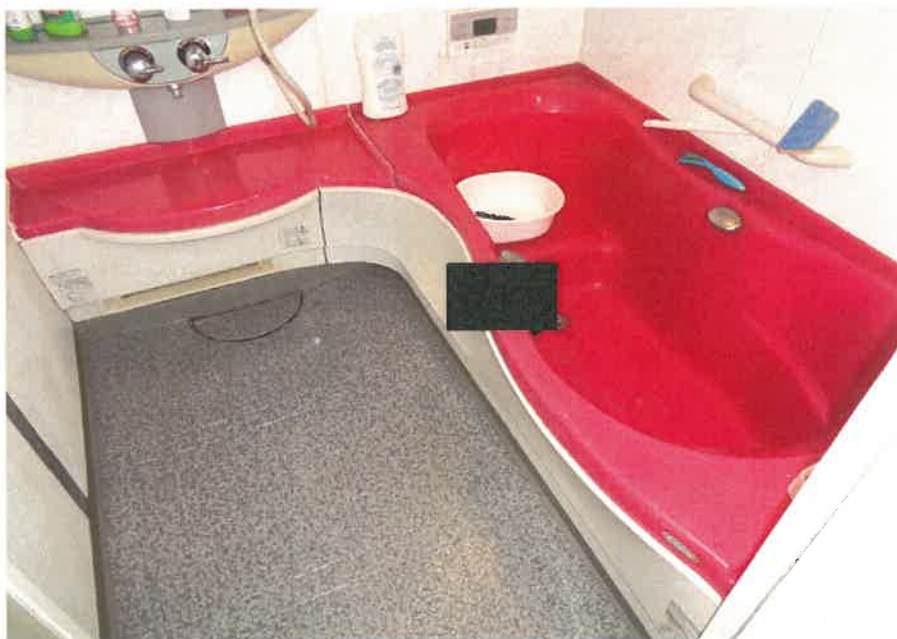
屋内の状況 浴室
