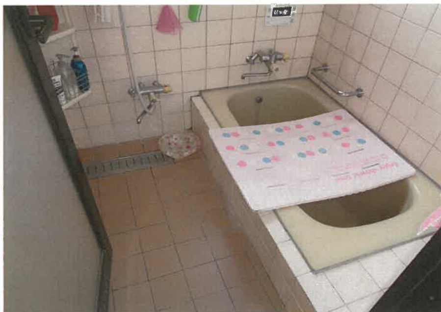
屋内の状況 浴室
