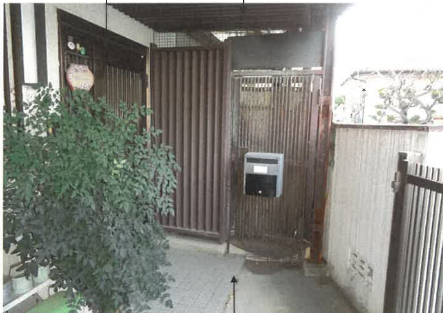
③ 本件建物 本件建物の未登記増築部分
