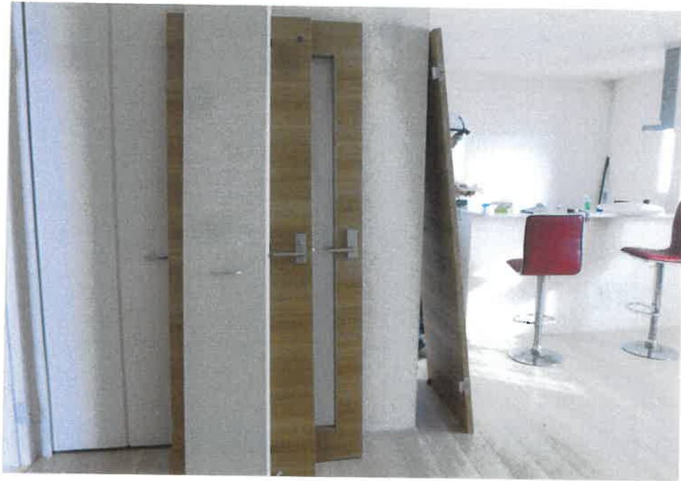
⑦屋内の状況 取り外された 扉の状況
