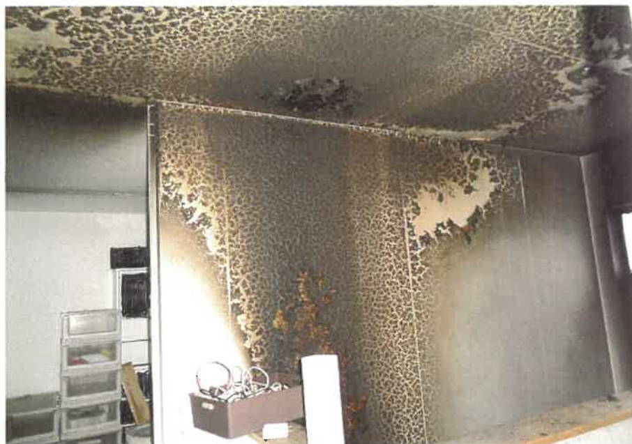
⑩ 屋内の状況 2階廊下
