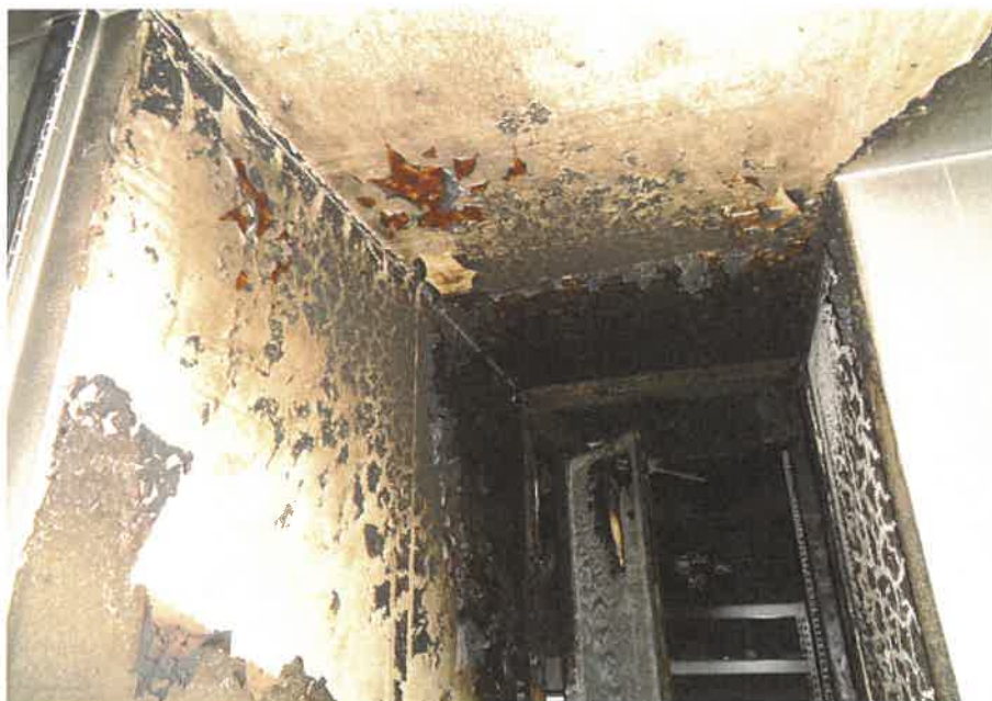
⑨ 屋内の状況 1階廊下
