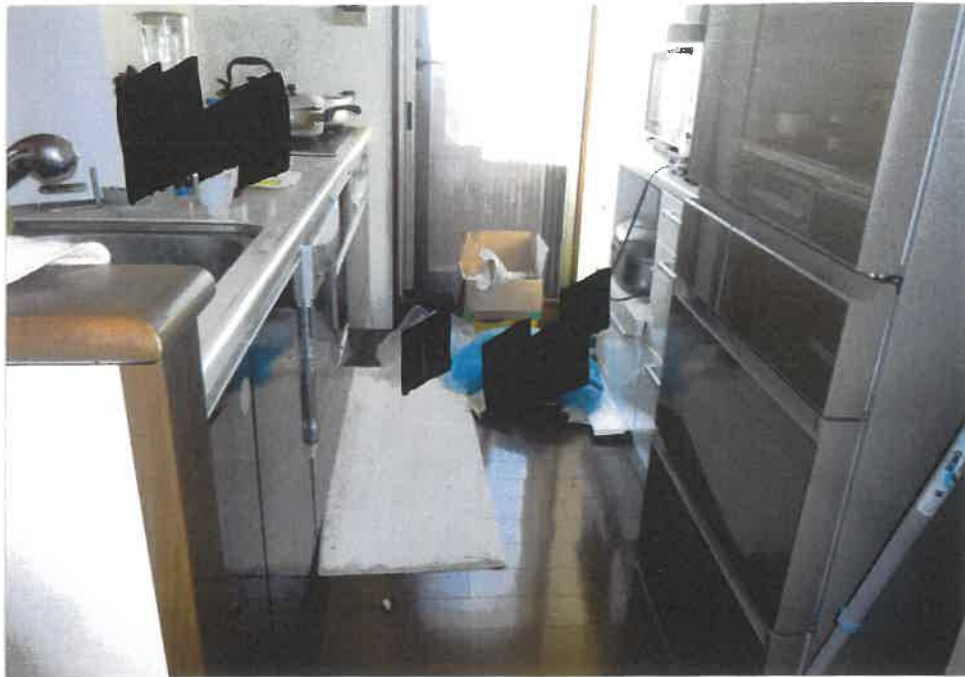
③屋内の状況 キッチン
