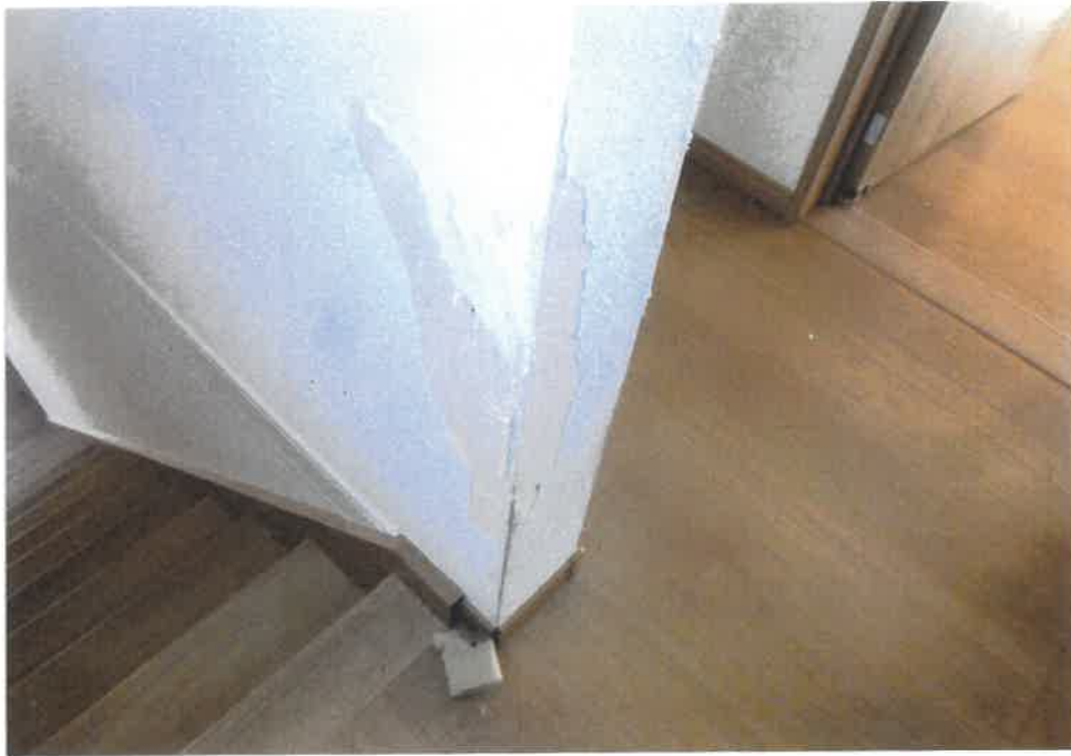
⑤屋内の状況 2階廊下の 壁の状況
