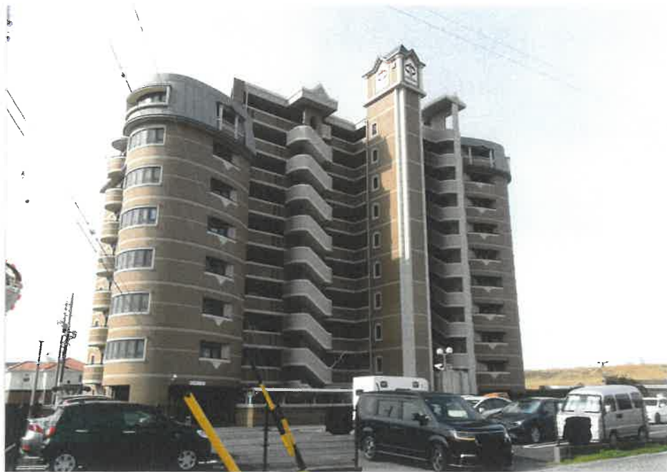
①本件建物を含む一棟の建物
