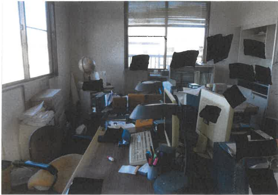
③屋内の状況 事務室② (主である 建物)
