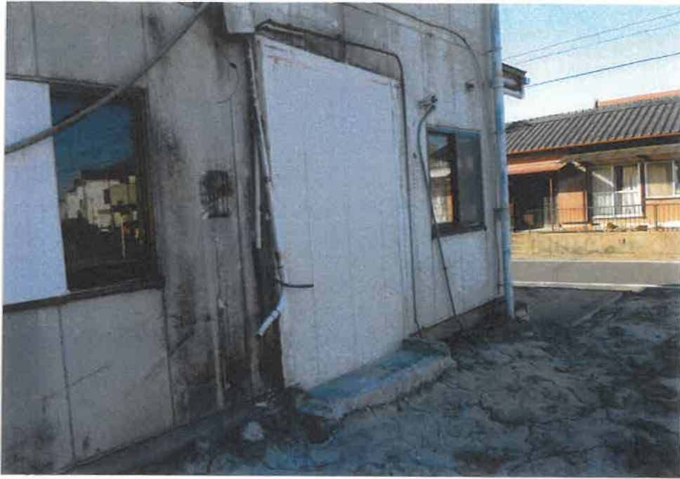
⑨屋外の状況 外壁の状況 (主である 建物)
