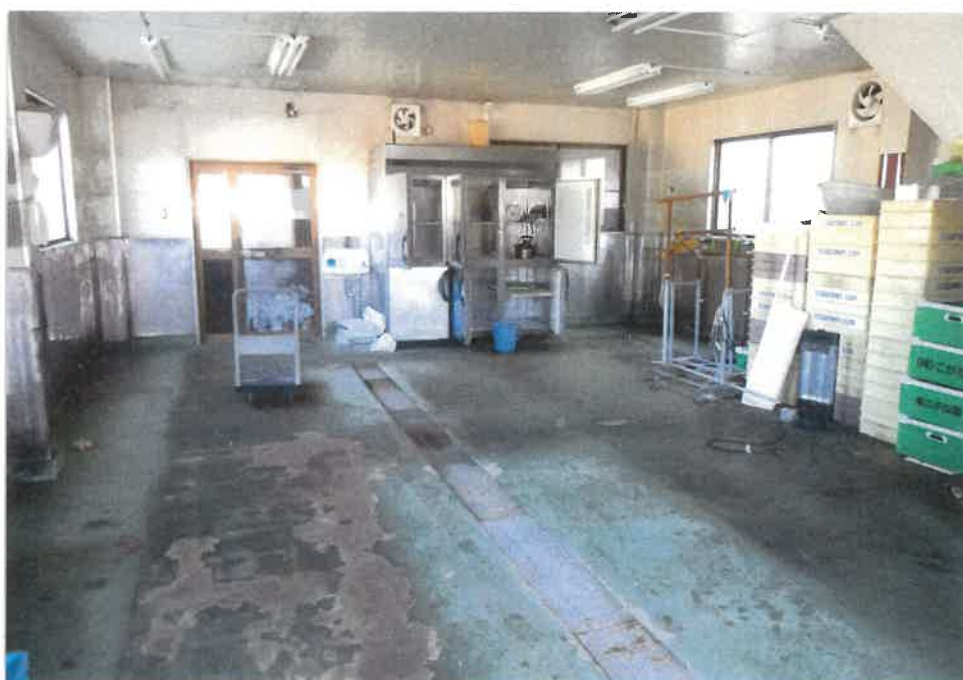
②屋内の状況 作業所② (主である 建物)
