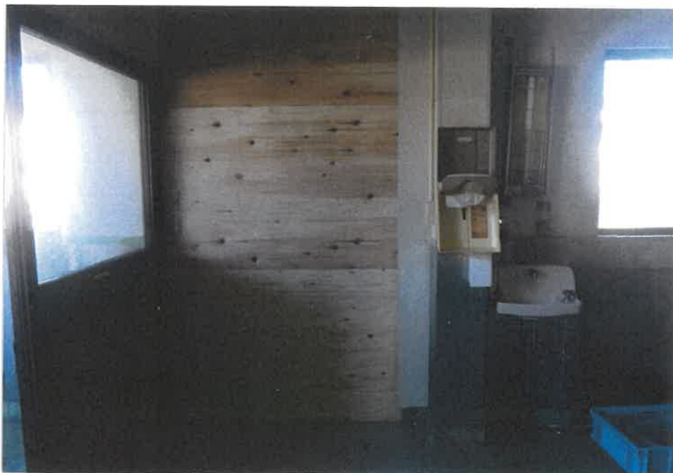
④屋内の状況 作業所②の壁 の状況 (主である 建物)
