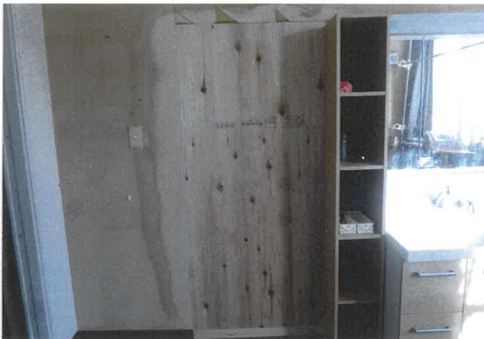
⑥屋内の状況 事務室③の壁 の状況 (主である 建物)
