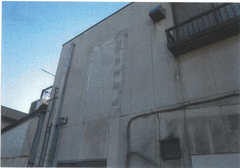
⑩屋外の状況 外壁の状況 (主である 建物)
