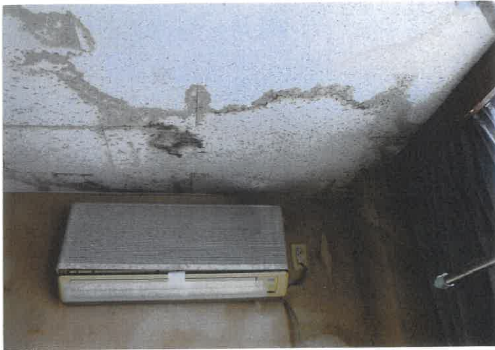
⑤屋内の状況 事務室③の 天井の状況 (主である 建物)
