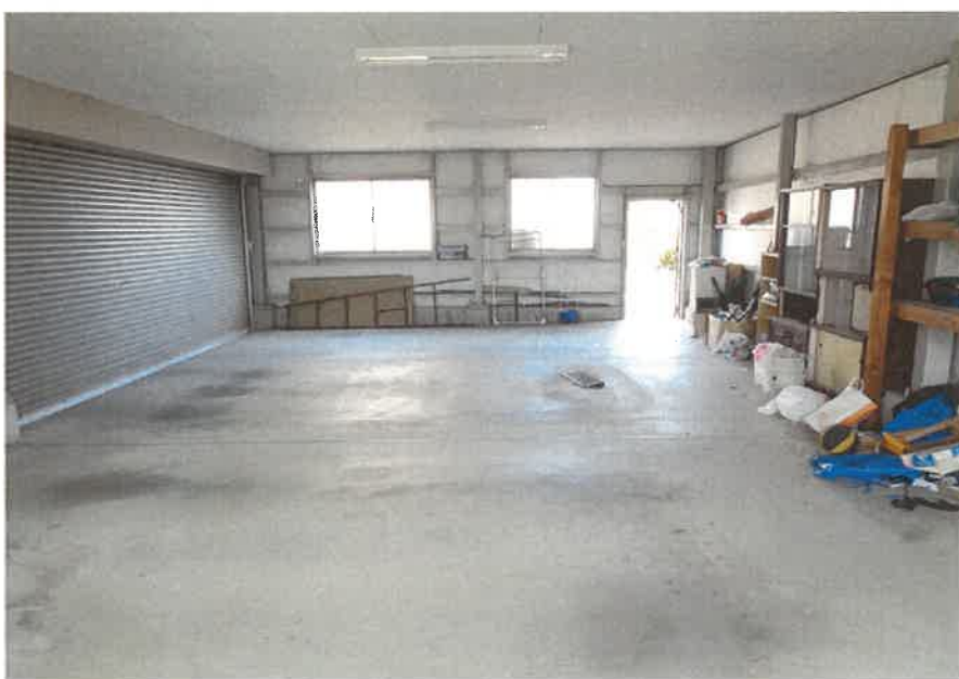
⑩ 屋内の状況 物件4建物(附属建物符号2)
