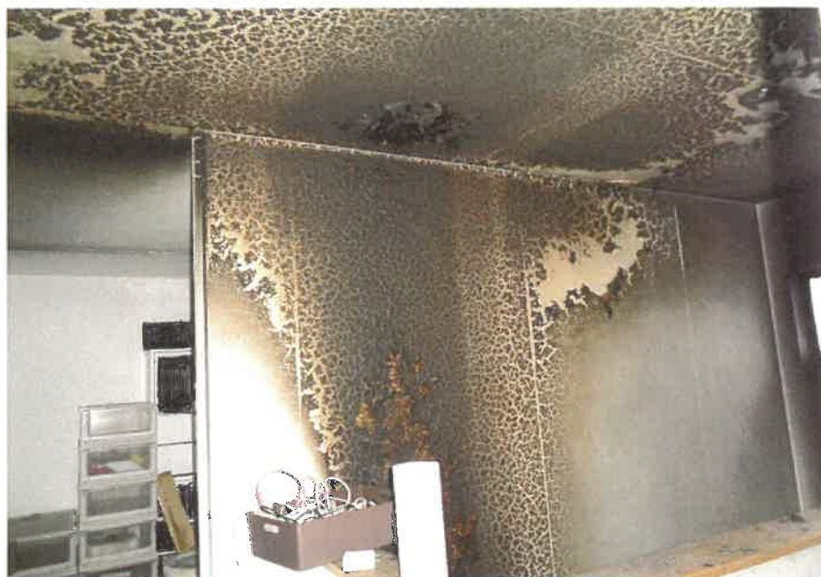
⑩ 屋内の状況 2階廊下
