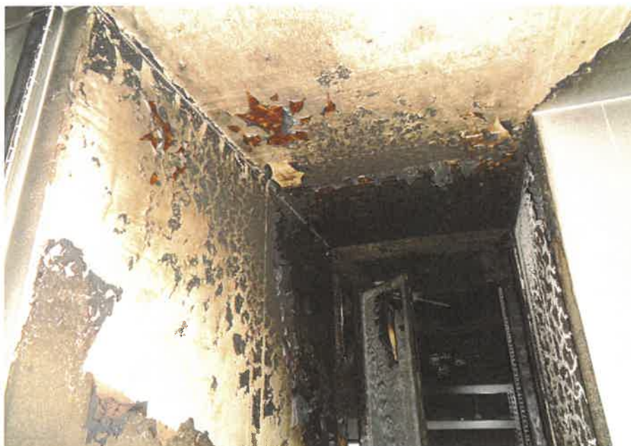
⑨ 屋内の状況 1階廊下
