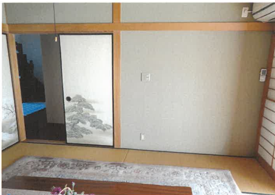
屋内の状況 和室1
