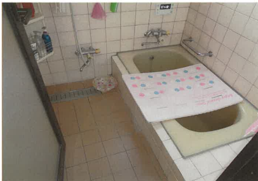
屋内の状況 浴室
