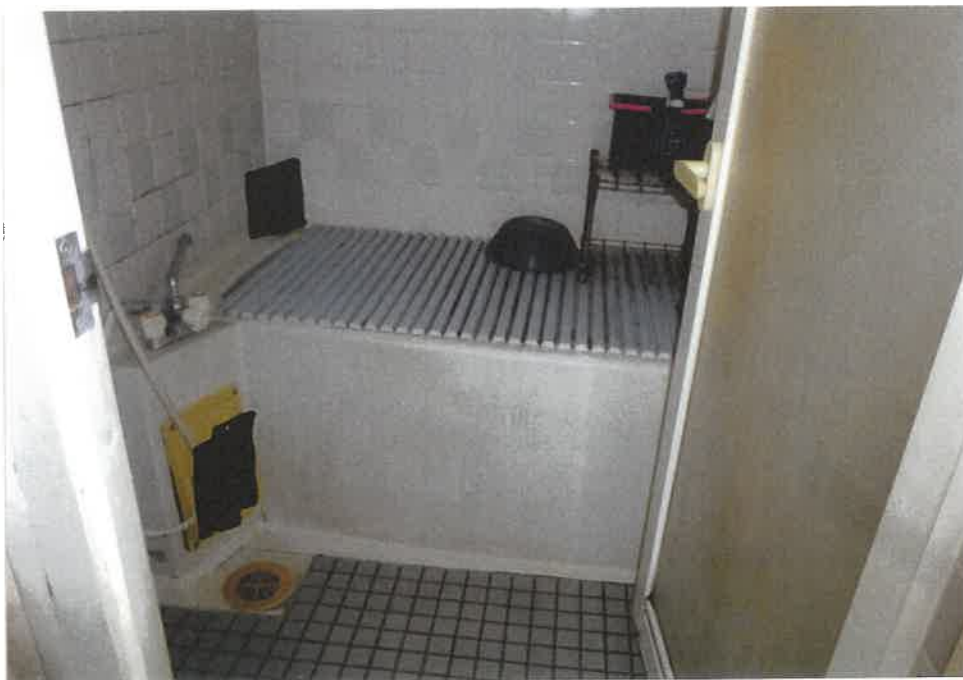
④屋内の状況 浴室
