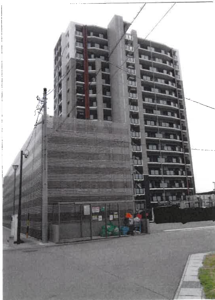
② 物件1建物を含む一棟の建物の外観
