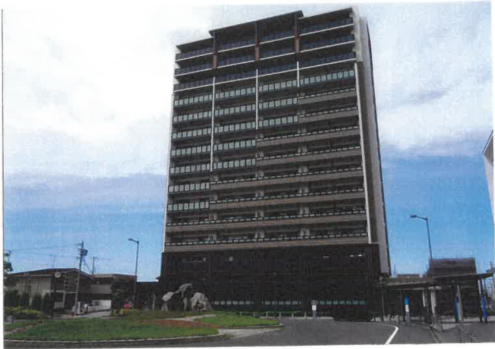
① 物件1建物を含む一棟の建物の外観
