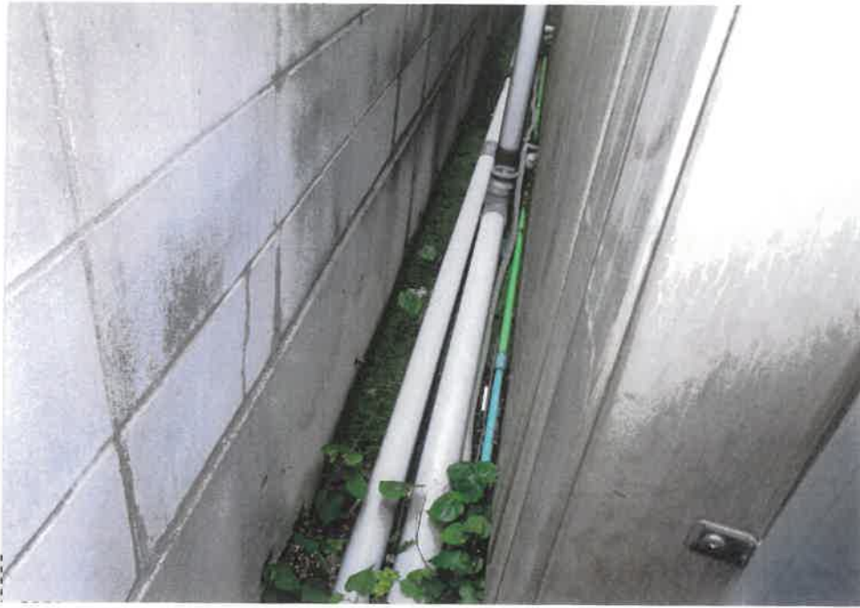
⑦屋外の状況 敷地部分北側 付近の状況
