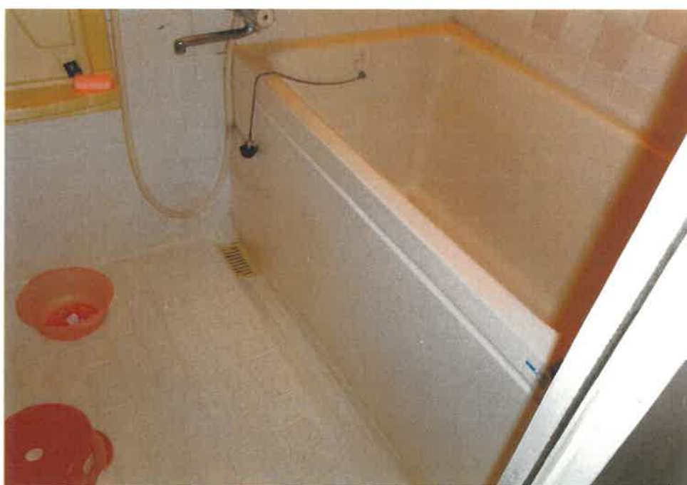
④屋内の状況 浴 室
