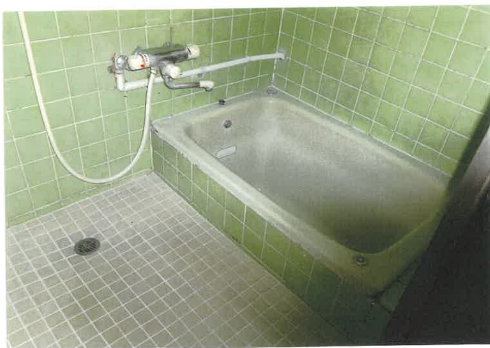
④屋内の状況 浴室 (主である 建物)
