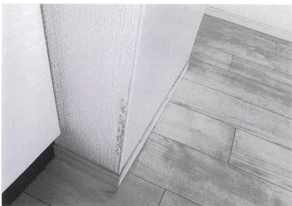
⑥屋内の状況 LDの壁の 状況
