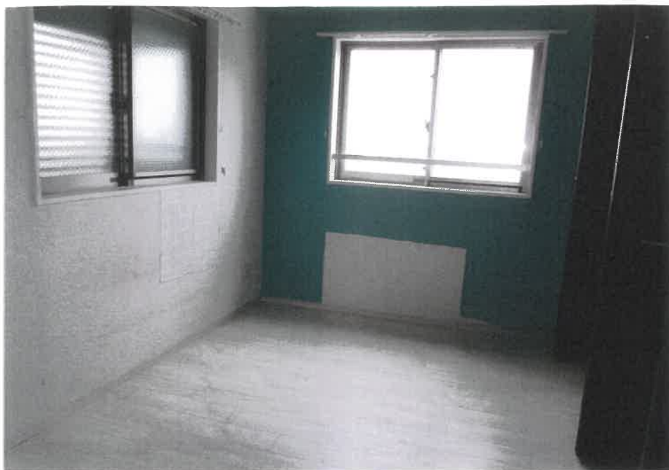
⑤屋内の状況 洋室1の壁 の状況
