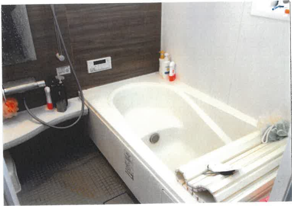
⑤ 屋内の状況（浴室）
