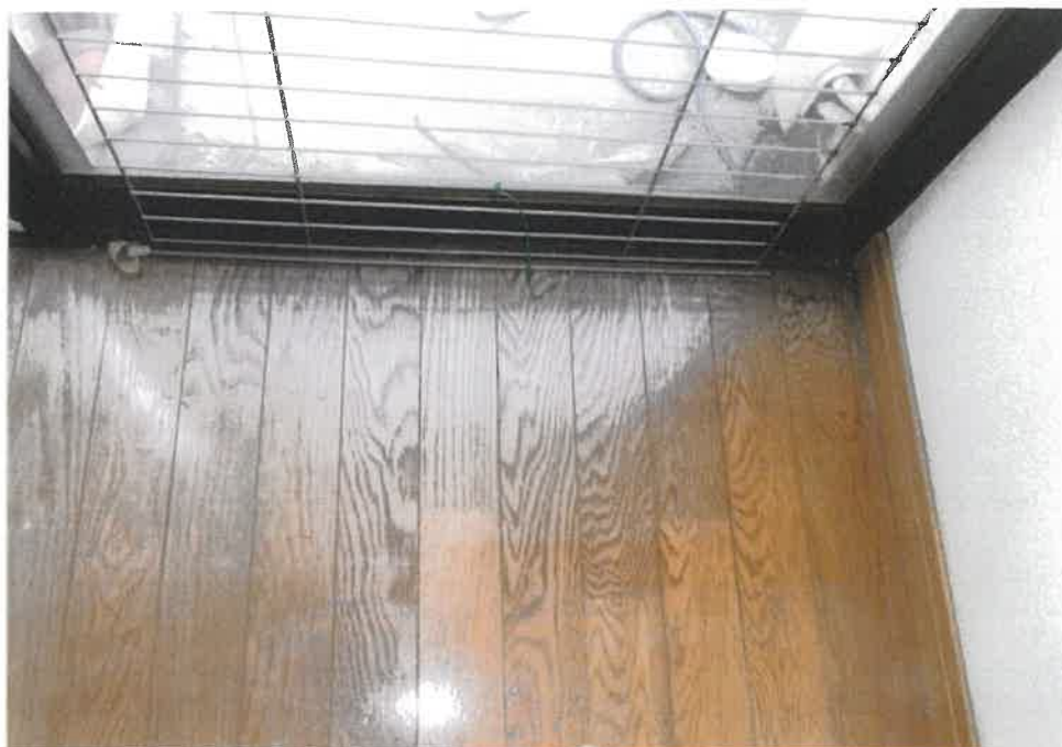
⑤屋内の状況 LDの床の 状況
