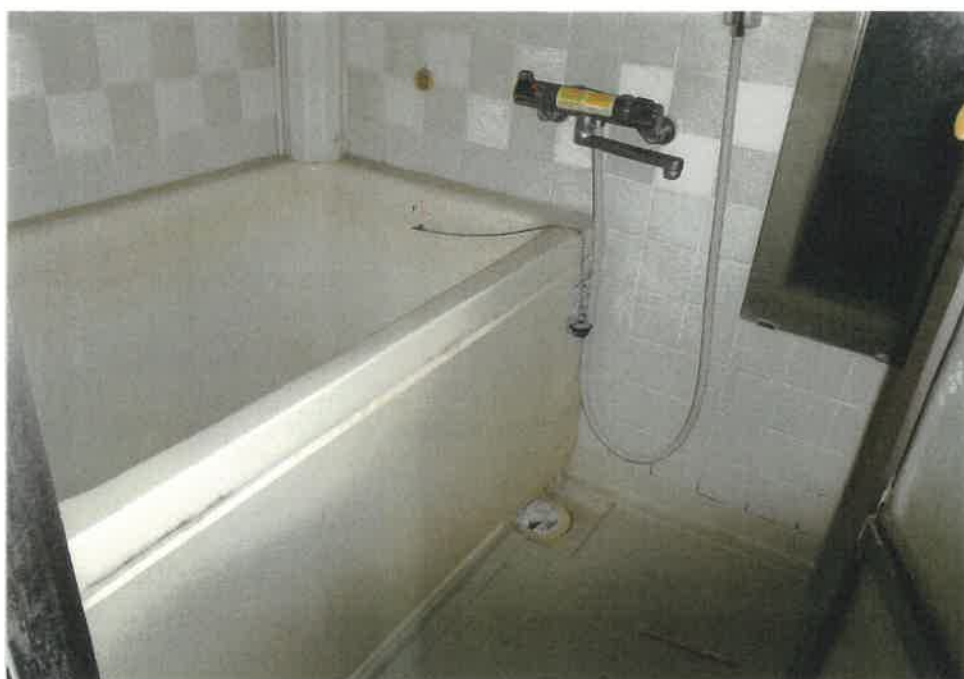
④屋内の状況 浴室
