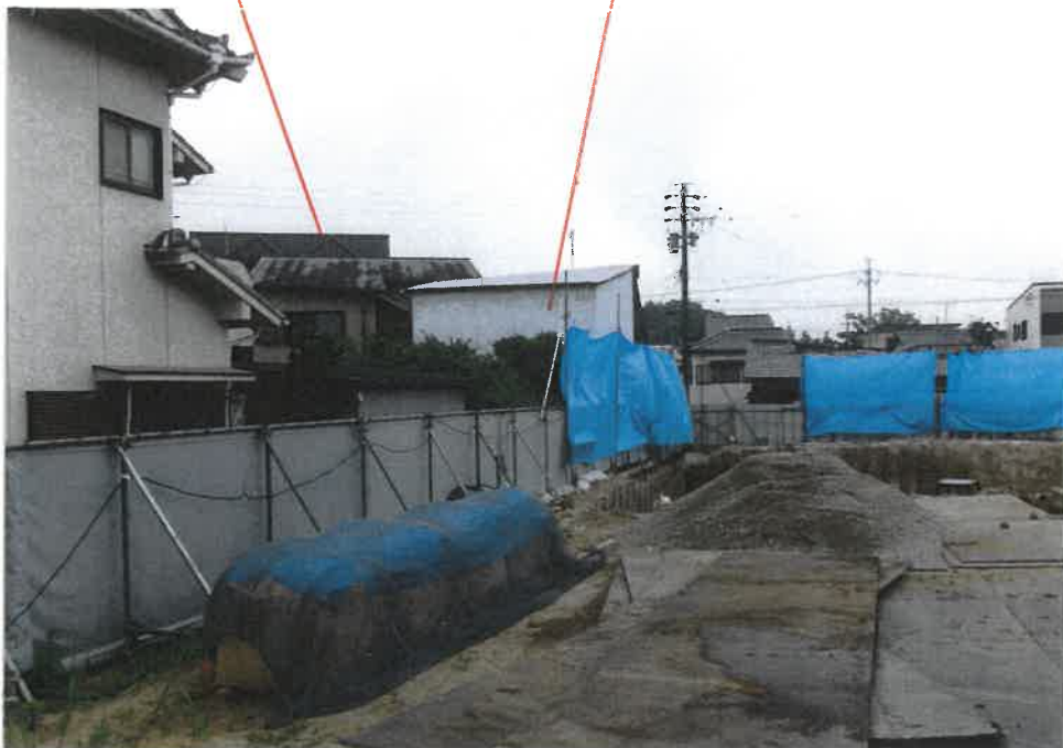
⑧屋外の状況 （北西側から 撮影）
