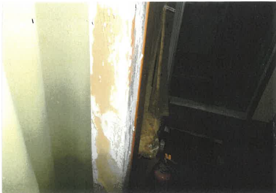
⑤屋内の状況 廊下の壁の 状況
