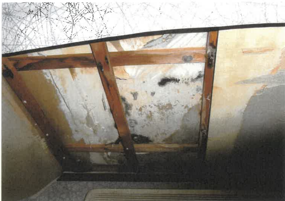
⑦屋内の状況 洋室1の天井 の状況
