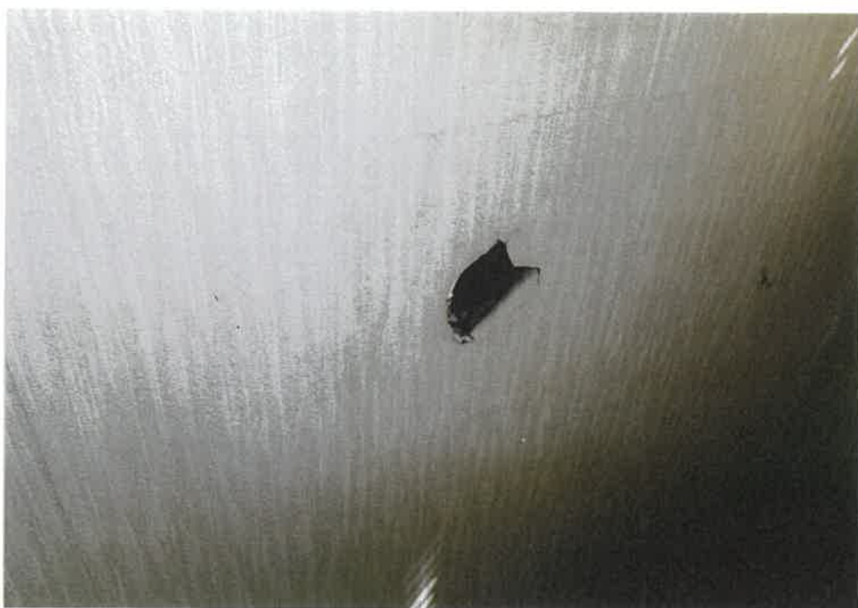
⑧屋内の状況 3階廊下の 壁の状況
