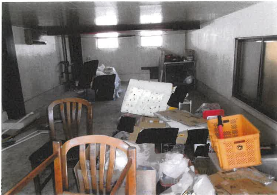
③屋内の状況 車庫
